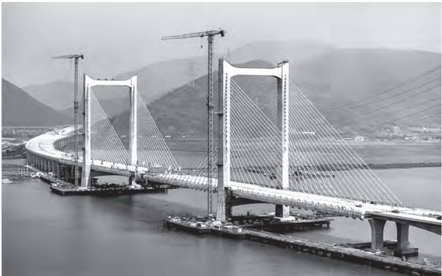
◆寧波舟山港六橫公路大橋一期工程。
